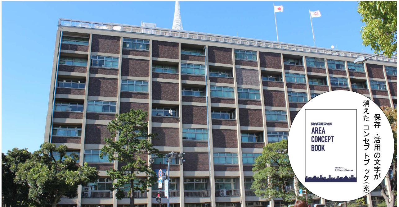
写真：現市庁舎
