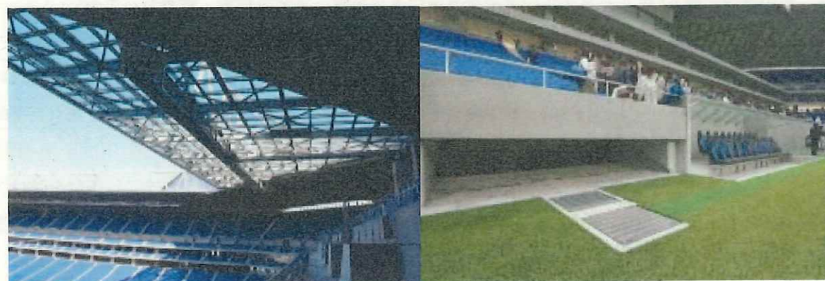
② 芝育成のため、南側の屋根を一部ガラス化、通風口の設置
